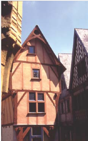
Maison à pans de bois ©J-F. Leroux
